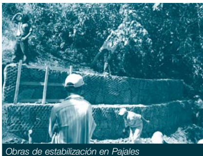
Obras de estabilización en Pajales
