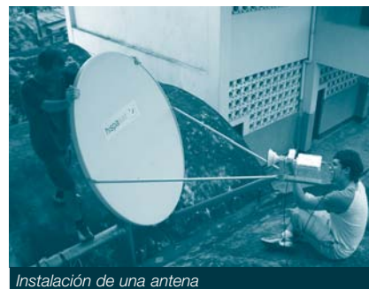
Instalación de una antena
