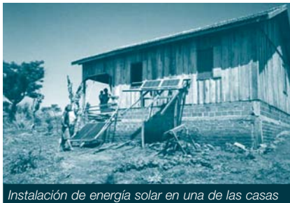
Instalación de energía solar en una de las casas
