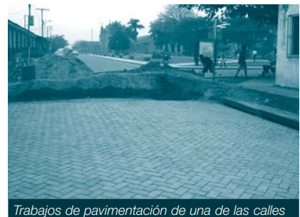
Trabajos de pavimentación de una de las calles
