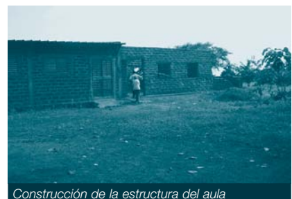
Construcción de la estructura del aula
